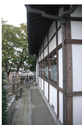
改修前の様子
