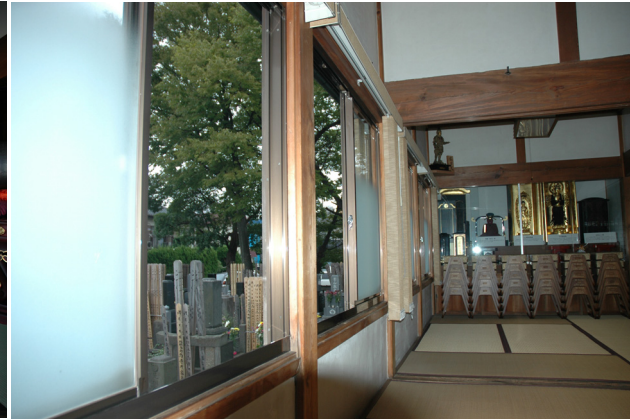
改修前の様子
