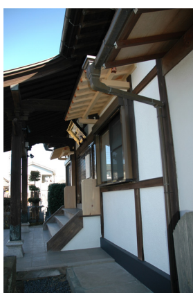
本堂正面（改修後）
