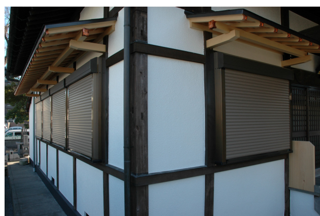
電動シャッターを閉めた改修後の様子（北側から）
