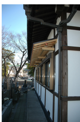
外に張り出した窓枠
