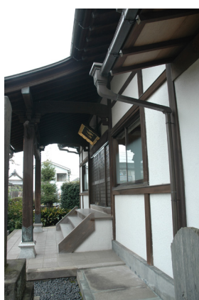
本堂正面（改修前）
