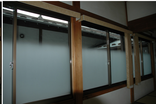
改修前の様子
