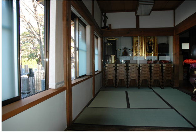
アルミサッシを外に出した新しい窓枠
